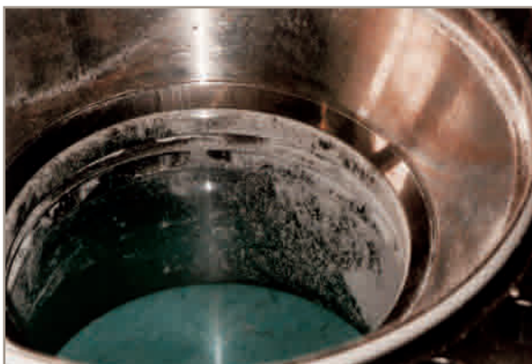
Bild 6 Kugelhahn, DN 250 Dichtring und Kugel nach einem Jahr im Polymer-Einsatz
